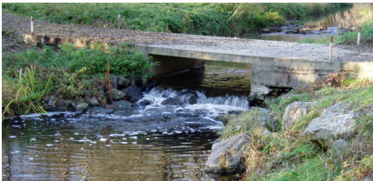
Abbildung 13-2: Absturz ca. 100 m vor der Mündung – durch den abgelösten Strahl für alle sprunghaften Arten völlig unpassierbar!
