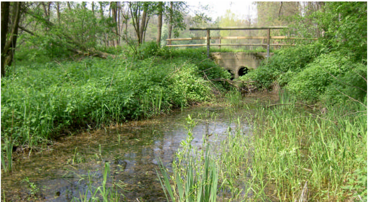
Abbildung 12-34: Rohrdurchlass am oberen Ende von Gewässer 14.
