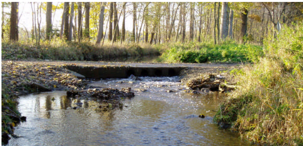
Abbildung 13-3: Querung mit Rohrdurchlass bei Oberau
