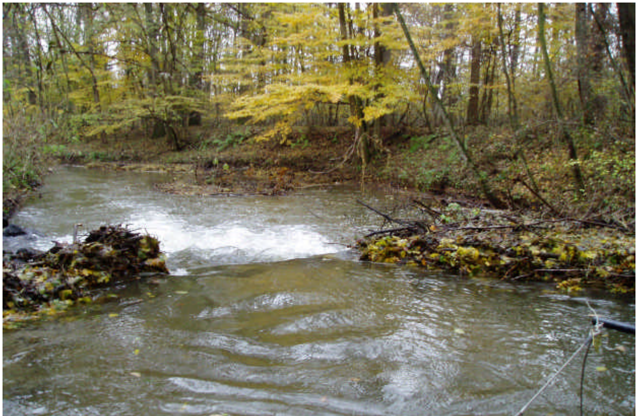
Abbildung 13-4: Sohlschwelle im Mühlbach bei Ratzenau
