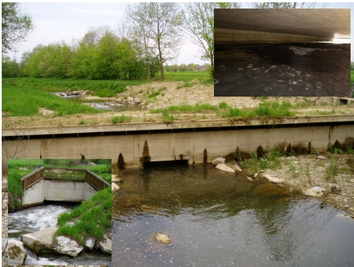
Abbildung 13-5: Querungsbauwerk des Mühlbachs über den Sassbach mit Blick auf die Einströmöffnung (li unten) und in den Betonschacht (re oben).
