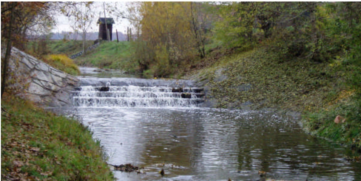
Abbildung 6-7: Unüberwindbares Querbauwerk oberhalb des Abschnitts „Fluttendorf“
