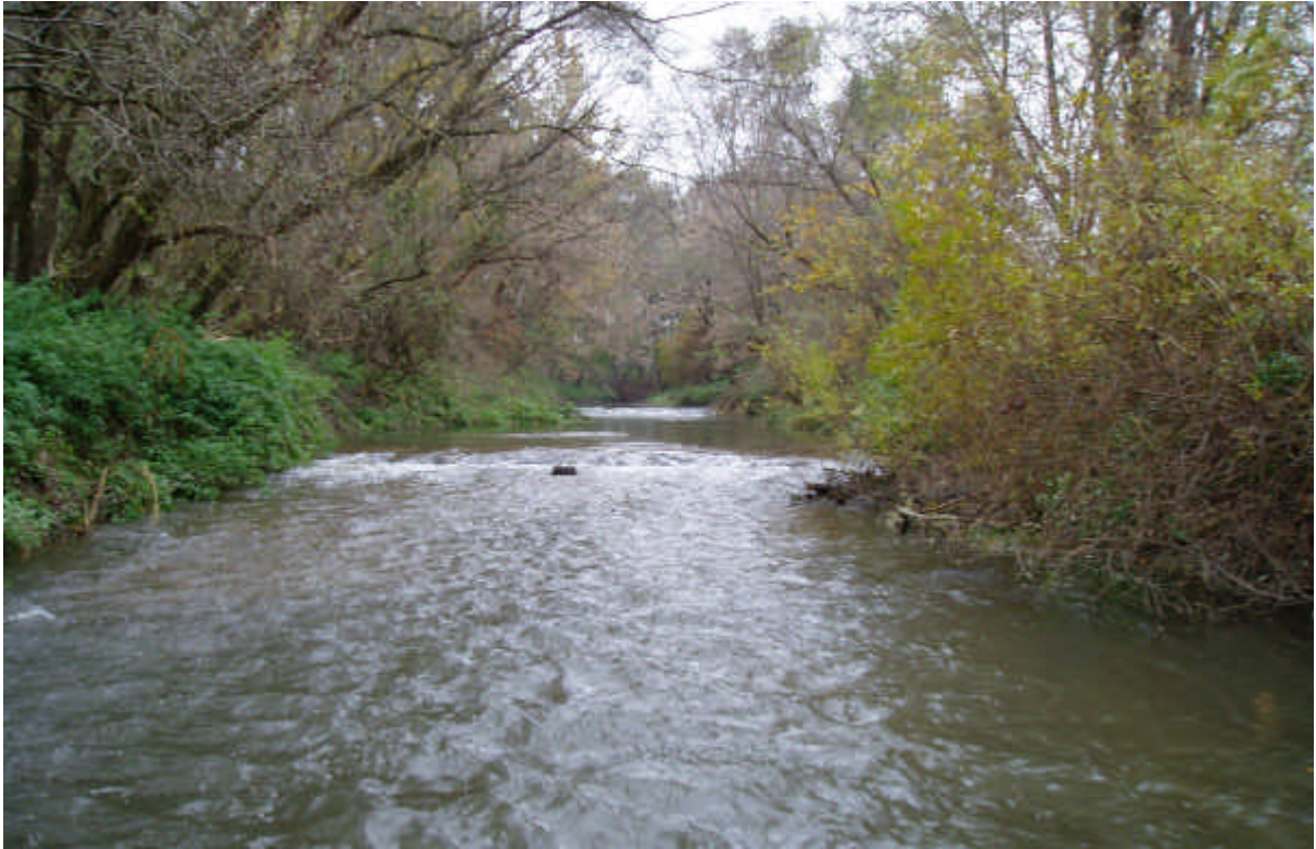
Abbildung 10-6: Im Bau befindliche Sohlschwellen oberhalb vom Abschnitt „Mündung“
