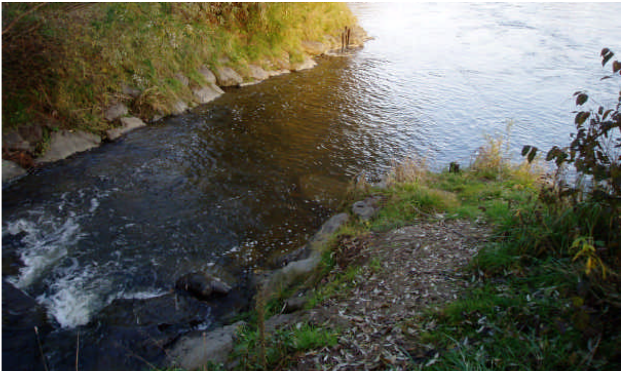
Abbildung 5-3: Abschnitt „Mündung“: Mündung des Schwarzaubaches in die Grenzmur
