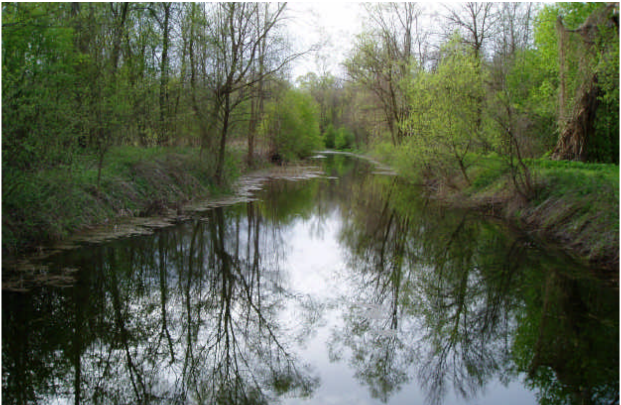
Abbildung 12-10: Oberer Teich, Ansicht vom Damm mit Rohrdurchlass (Gewässer 5)
