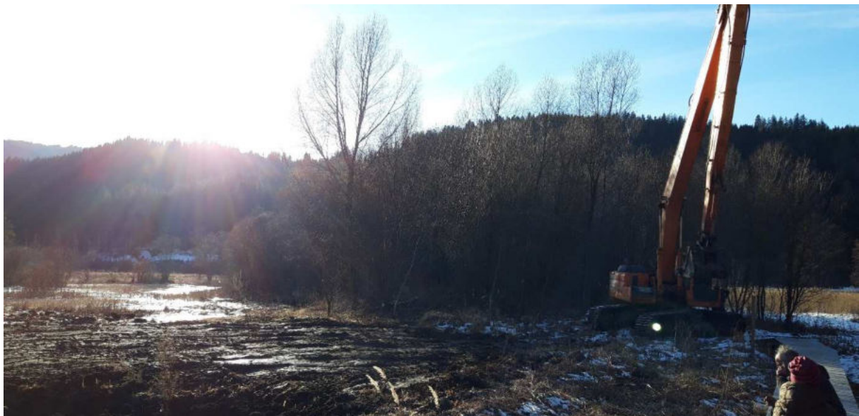
Abbildung 1: Baggerarbeiten der Firma Zechner
