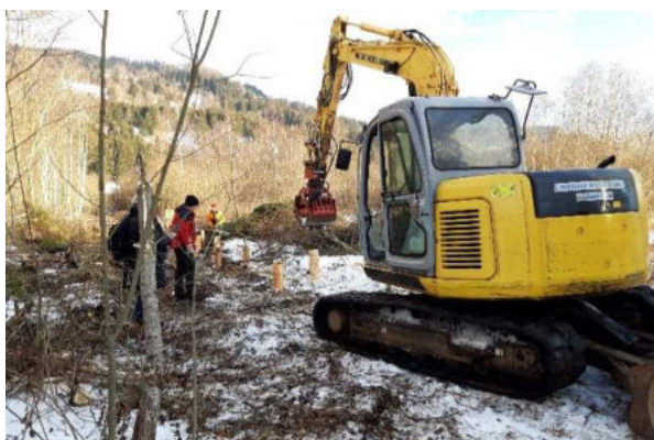
Abbildung 3: Stegerneuerung Firma Wandelnig
